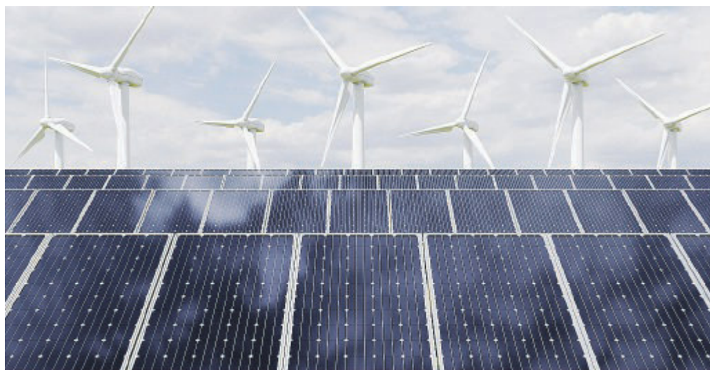
FOTOVOLTAICO Molte piccole imprese hanno già realizzato impianti per il risparmio energetico contando sul credito d'imposta previsto da Transizione 5.0
