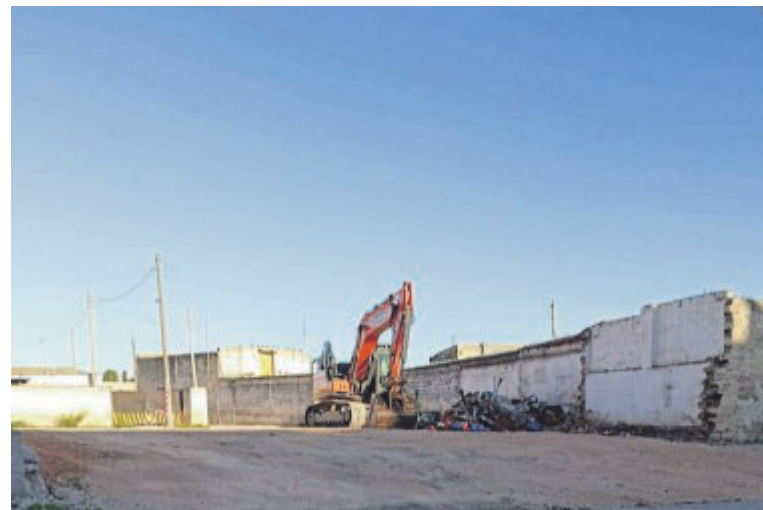
LAVORI IN CORSO Demolizione dei ruderi del Comparto 17, periferia di ponente
