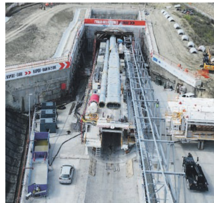
LO SCAVO La nuova galleria di Grottaminarda sulla Napoli-Bari
